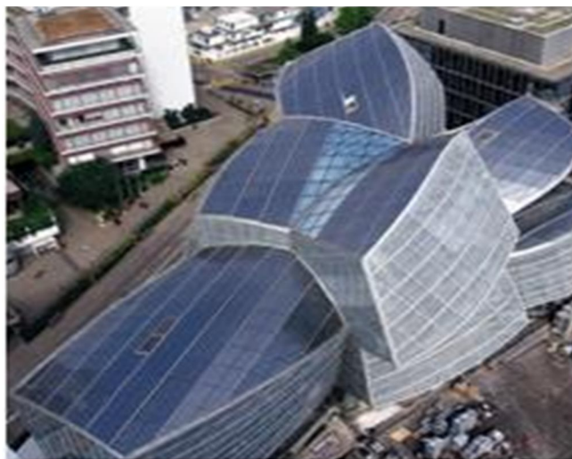
شکل (۳-۳): نمونه‌ای از نصب آرایه‌های فتوولتاییک در نمای ساختمان
