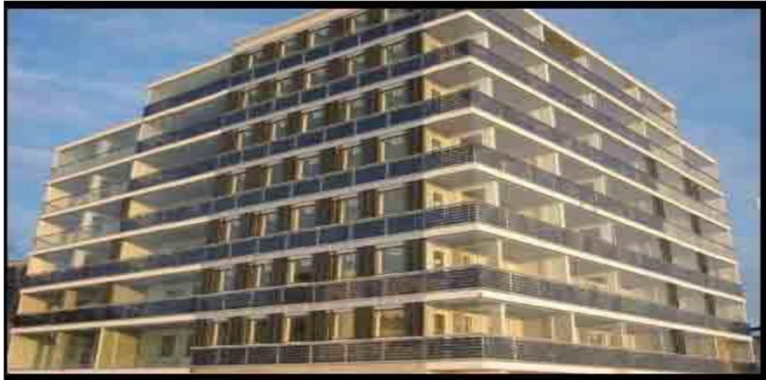
شکل (۳-۶): نصب آرایه‌های فتوولتاییک به عنوان نرده بالکن
